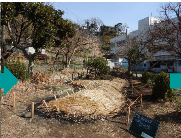
2022年2月11日施工後
